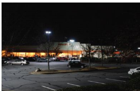
Iluminação: lâmpadas de vapor metálico de 1000W Gasto Anual: US$ 13,800
