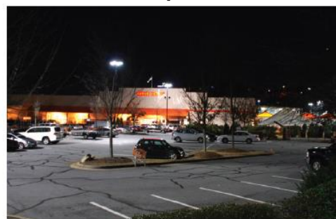
Iluminação: lâmpadas de vapor metálico e gHID 320W Gasto Anual: US$ 3,990
