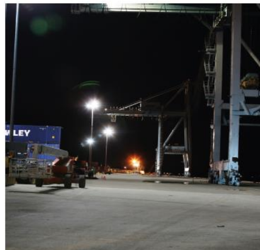
Iluminação: lâmpadas de vapor metálico e gHID 320W Gasto Anual: USD $ 32,390
